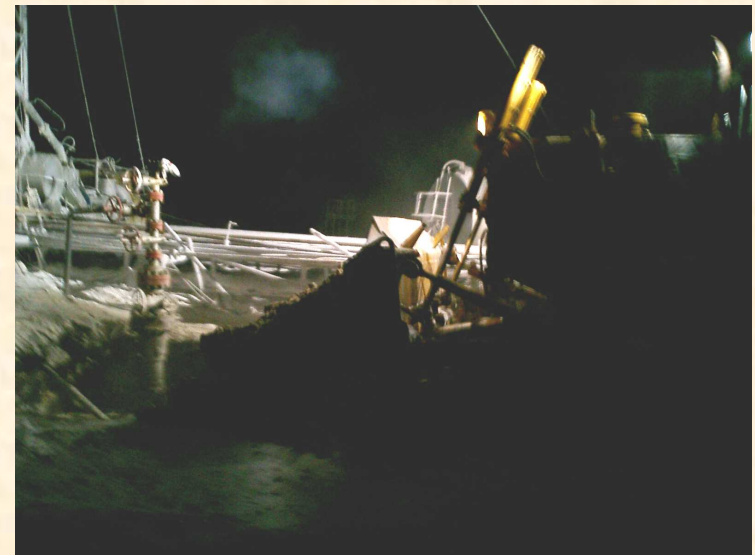
Бульдозер заполняет песчано-гелевой смесью приустьевую воронку
