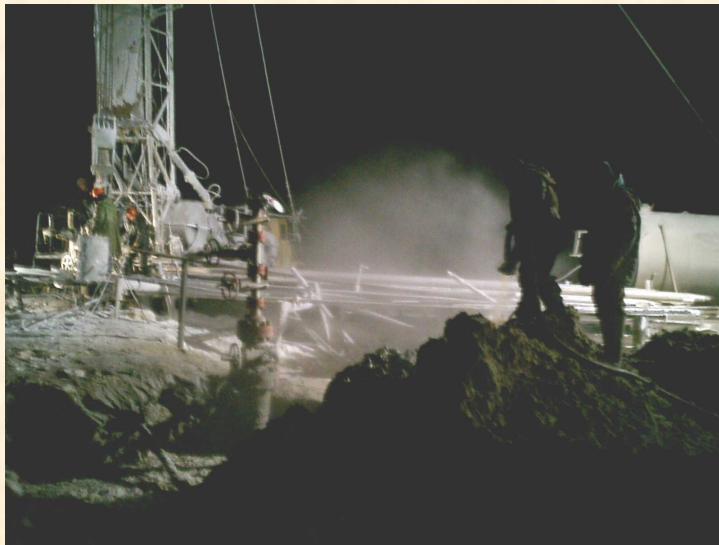
Обработка песка раствором криогеля
